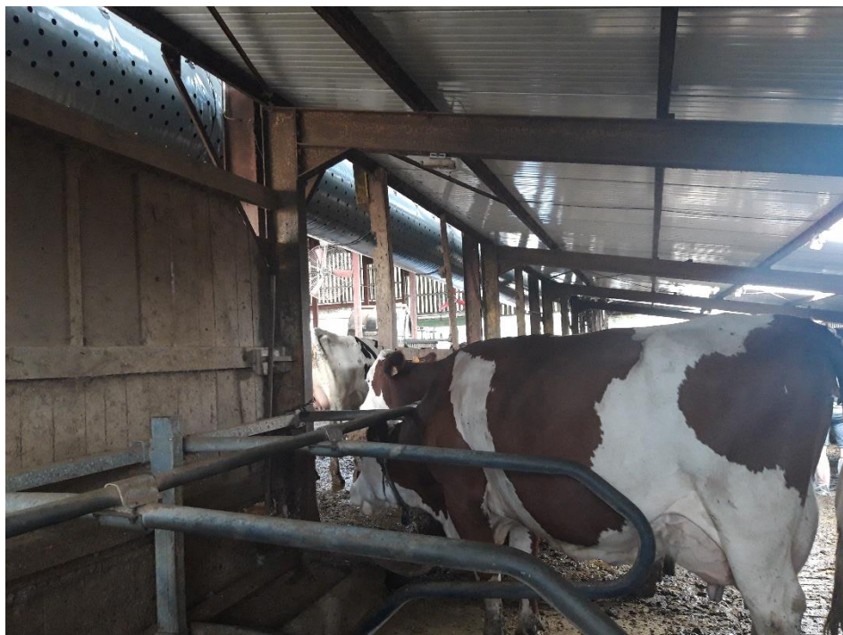
La gaine perforée longitudinale est positionnée au-dessus des logettes
